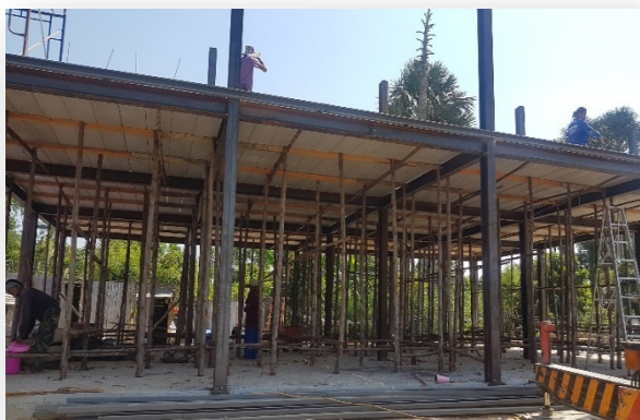
อาคารรวบรวมกุ้งและคัดแยก 2 ชั้น ขนาด 192 ตารางเมตร (อยู่ระหว่างการก่อสร้าง)
